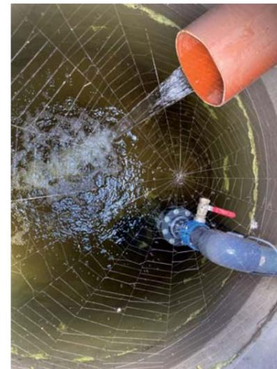
Abb. 10: Recyclingschacht mit Drainwasserzulauf und Tauchpumpe
