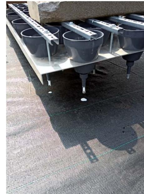
Abb.5: Druckschablone zur Markierung der Topfpositionen
