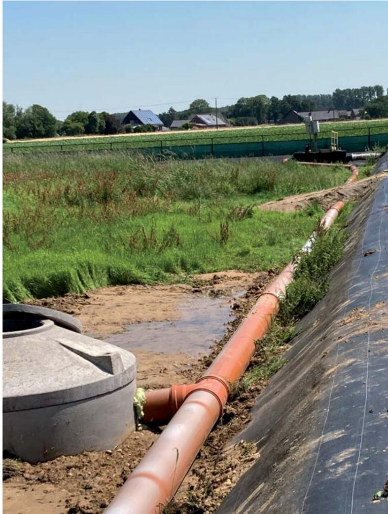
Abb. 9: Drainwasser-Leitung mit Messstation im Hintergrund und Recyclingschacht vorne links
