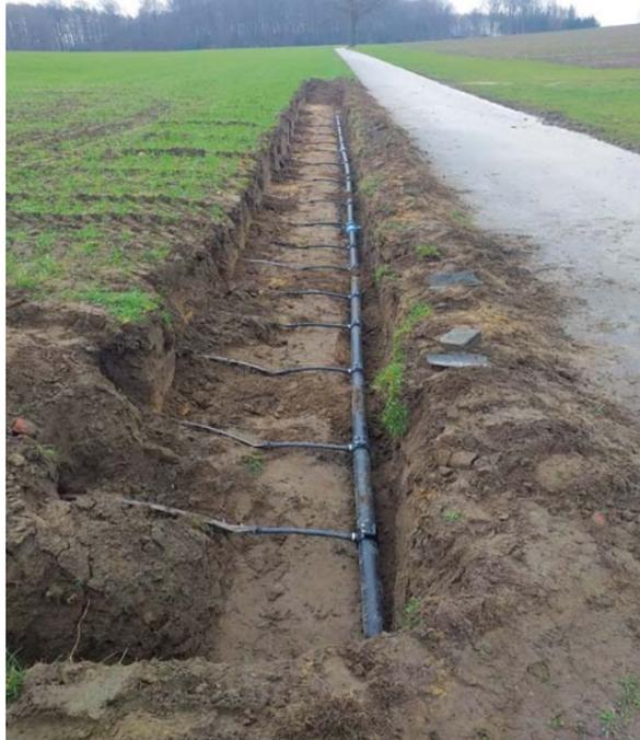
Abb. 2: Kopfleitung mit Abgängen nach Einbau im März 2023
